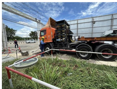
รูปที่ 6 ล้างล้อรถ/จุดล้างล้อ
